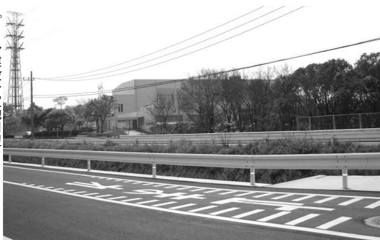
プール建設予定地周辺
