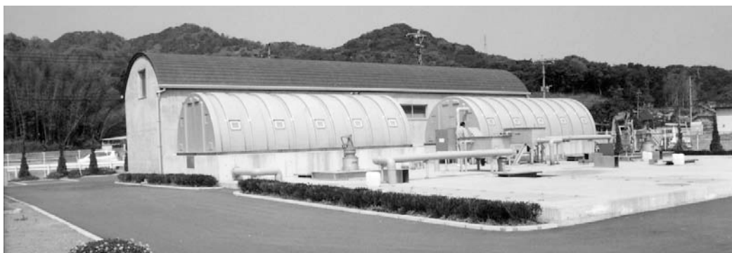
片島地区農業集落排水場
