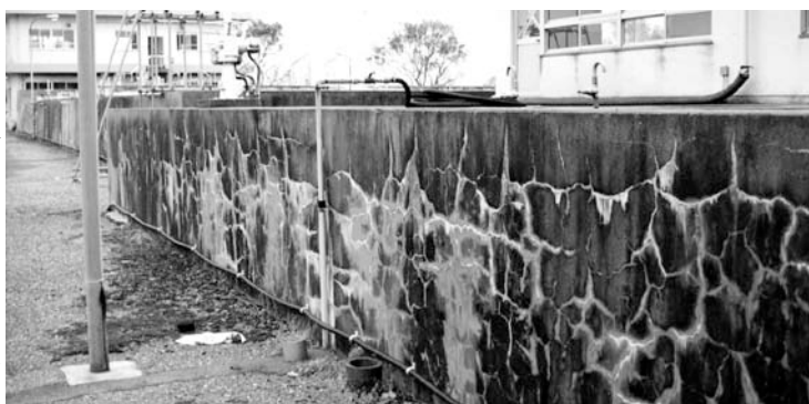
改良工事が待たれる二崎浄水場
