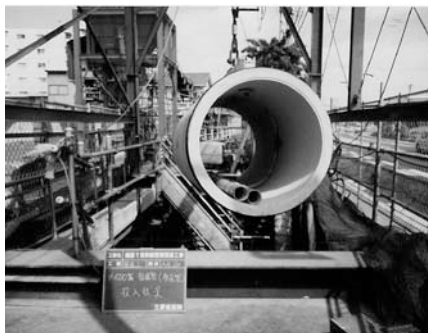
急がれる公共下水道工事
