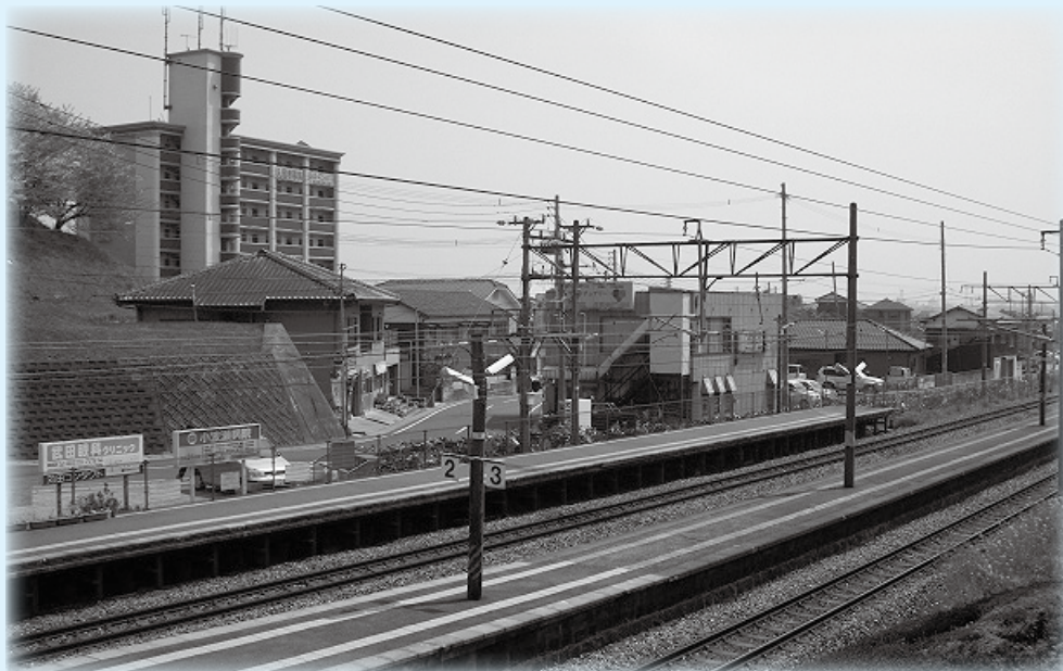
現在の小波瀬西工大前駅周辺
