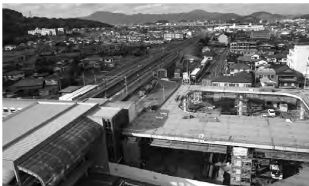
整備中のJR荻田駅東側
