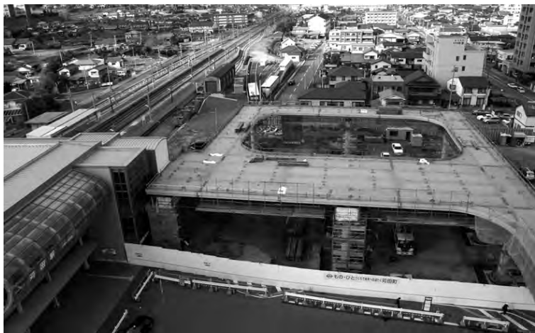
工事が進むデッキ部分
