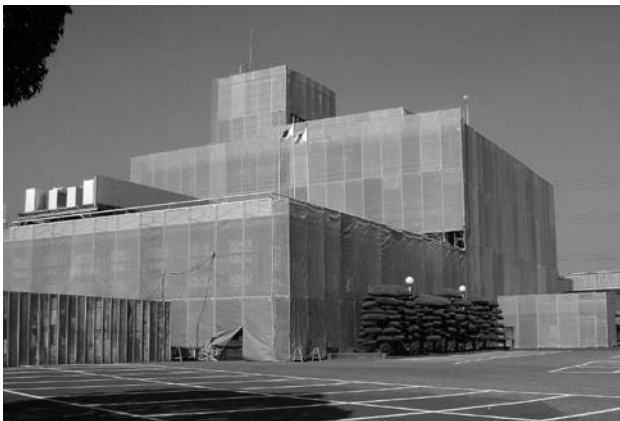
庁舎改修工事
