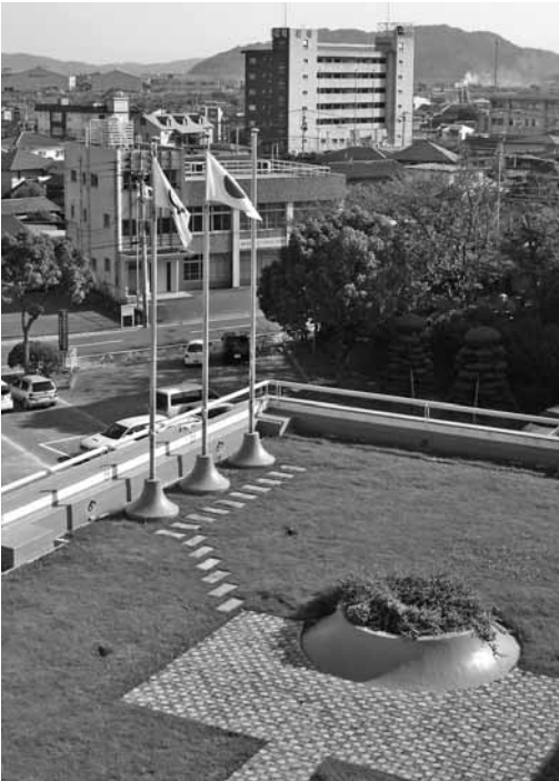
庁舎の屋上緑化
