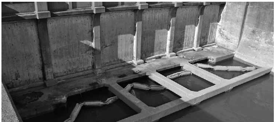
汚濁防止ネット(臨空産業団地)
