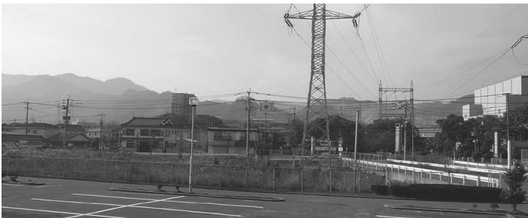
プール建設予定地
