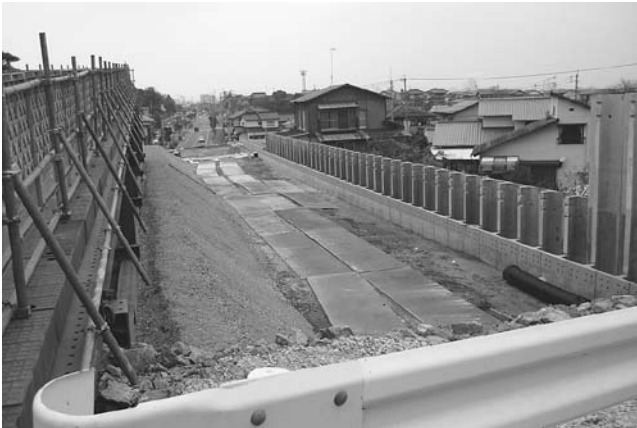
須磨園南原曽根線緑ヶ丘トンネル工事
