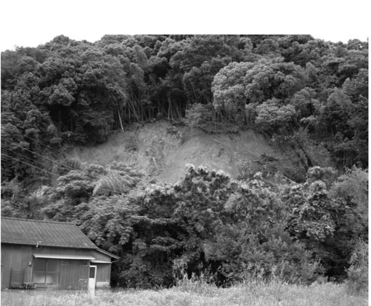
豪雨で崩落した山林（二崎地区）
