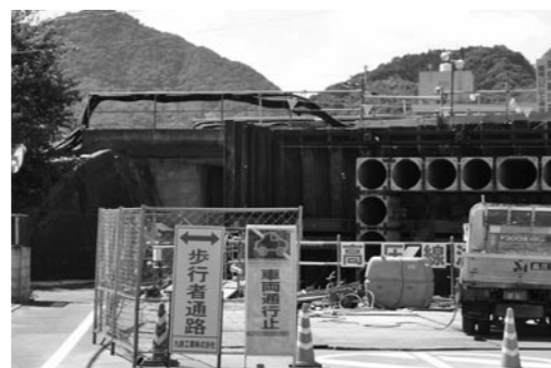
工事が進む井場川JR下拡幅工事
