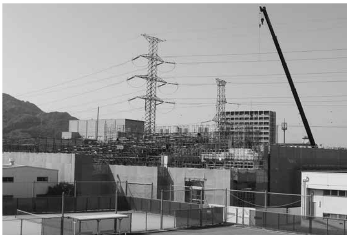
建設中の町民温水プール
