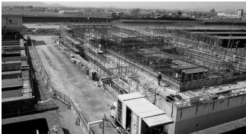
建設が進む二崎浄水場
