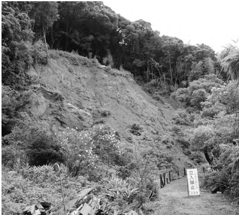
崩落した二先山
