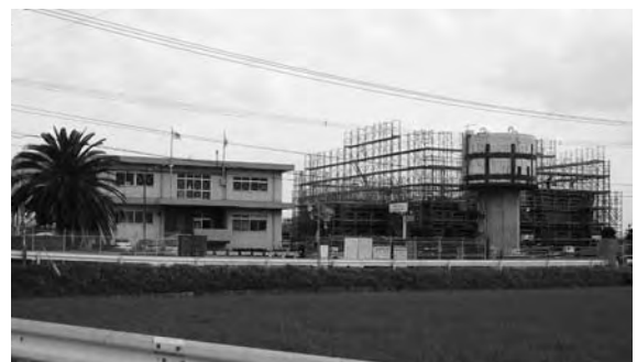
二崎浄水場改修工事
