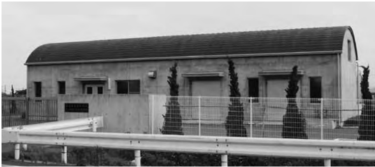
片島地区 汚水処理場
