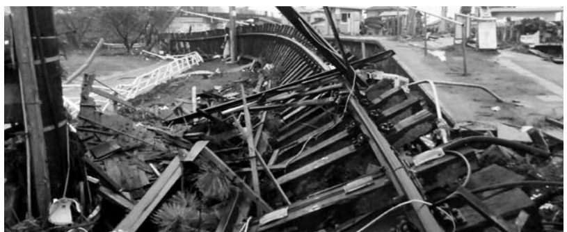
津波により被災した線路
