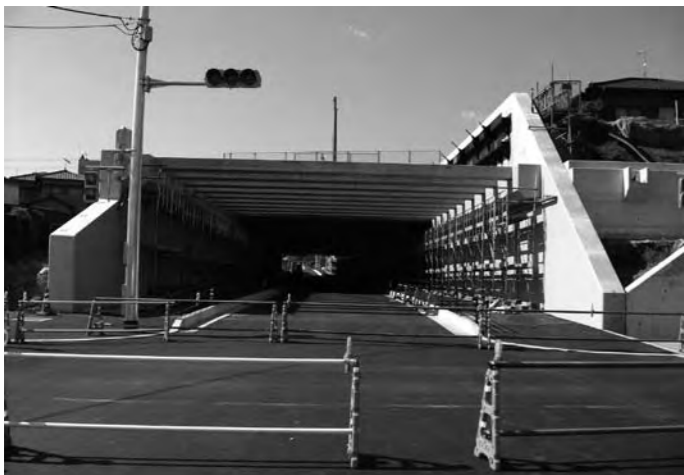
緑ヶ丘下の県道改修事業
