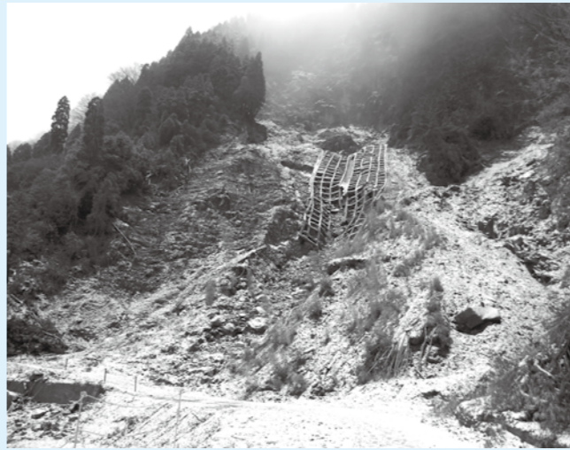
北部九州豪雨による土砂崩れ
