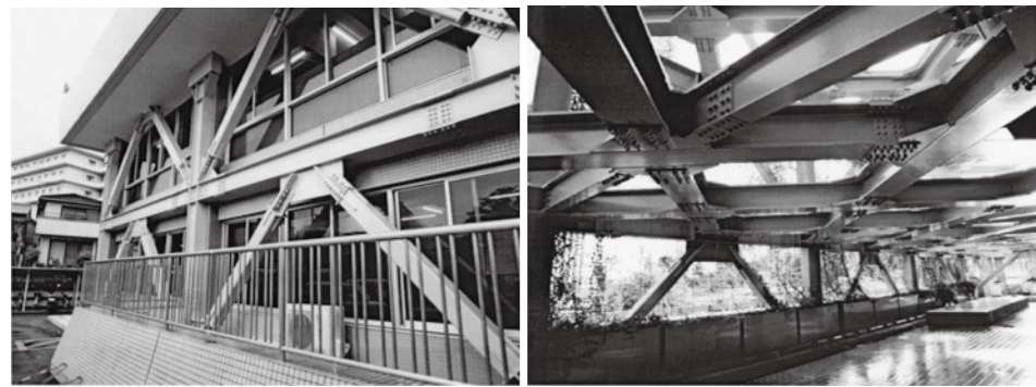
耐震補強された松阪市庁舎
