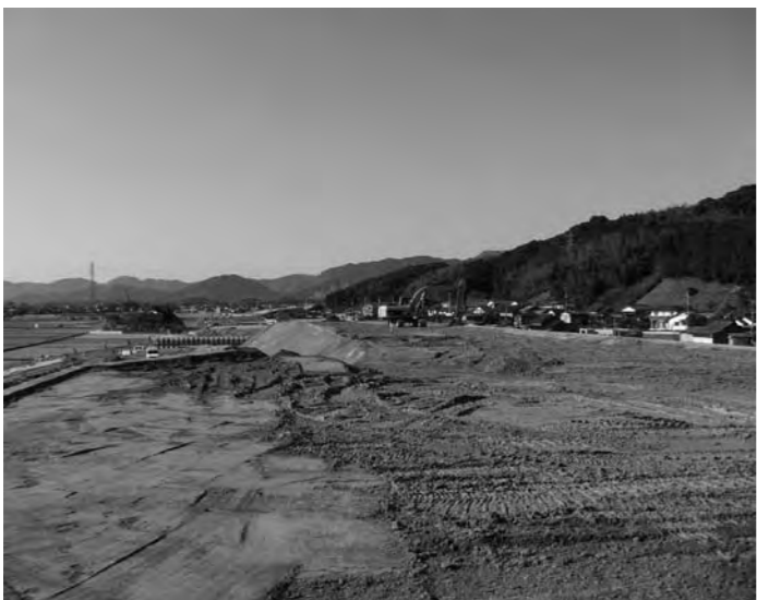
工事中の201号バイパス（行橋インター関連）
