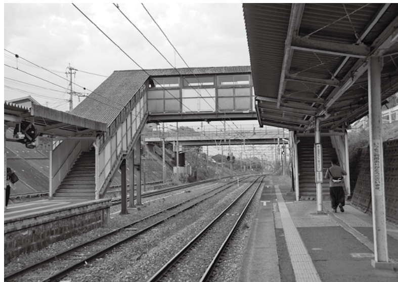
JR 小波瀬西工大前駅ホーム
