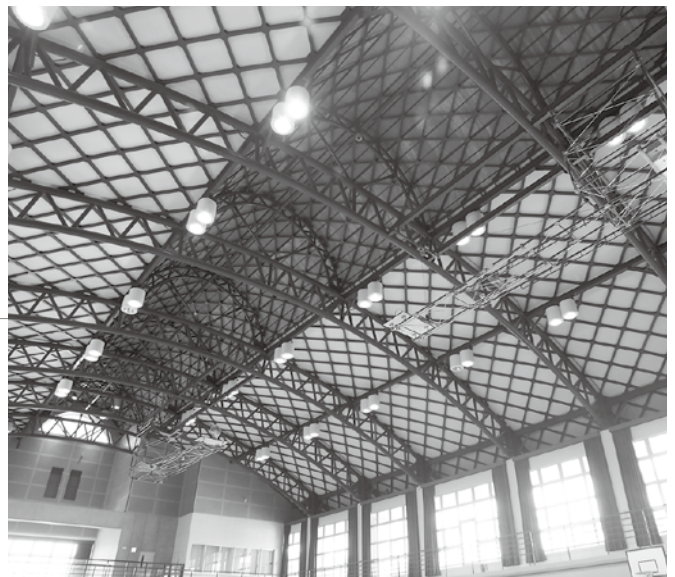
荇田小学校体育館
