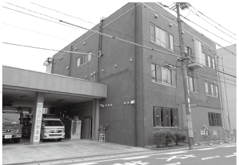
改修中の消防庁舎
