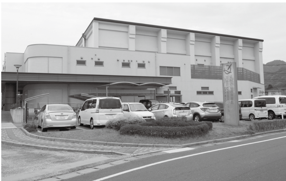
菊田町町民温水プール
