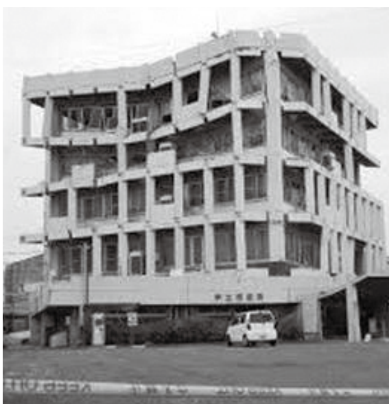
倒壊した宇土市役所
