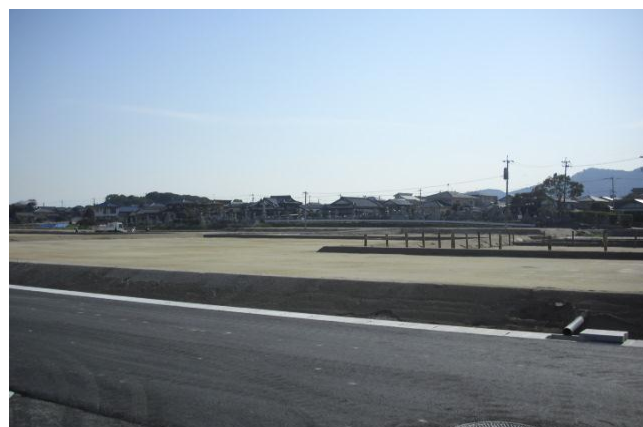
平成27年度仮換地引渡し箇所（25街区）
