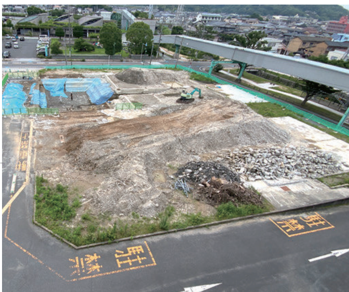
新庁舎建設予定地
