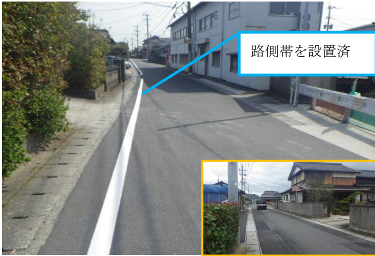
3-1. 大字尾倉近衛橋付近旧国道
